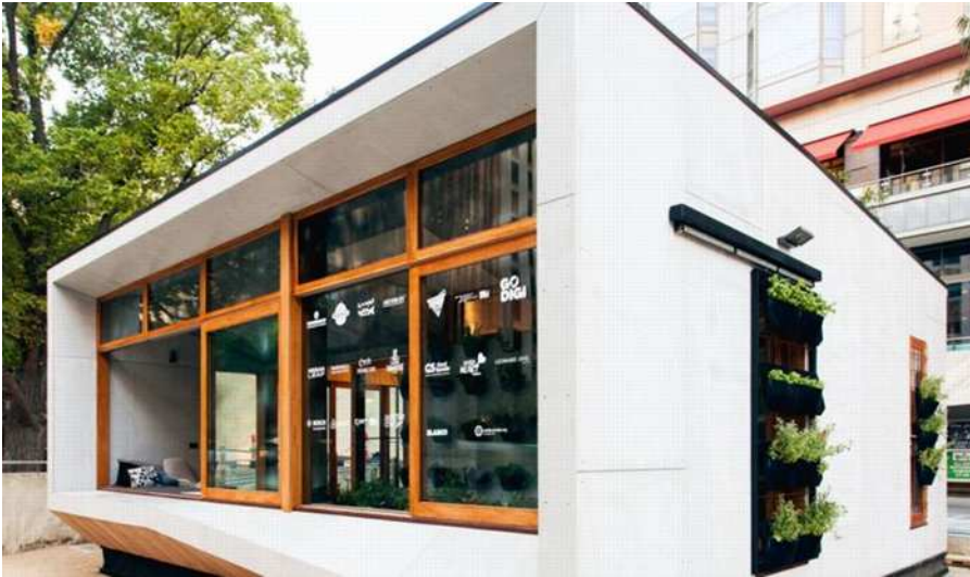
“Archiblox” is een mini-huis dat ontworpen werd door een Australische firma. Een dergelijk prefab-huisje worden opgebouwd in één dag en produceert meer energie dan het verbruikt.
