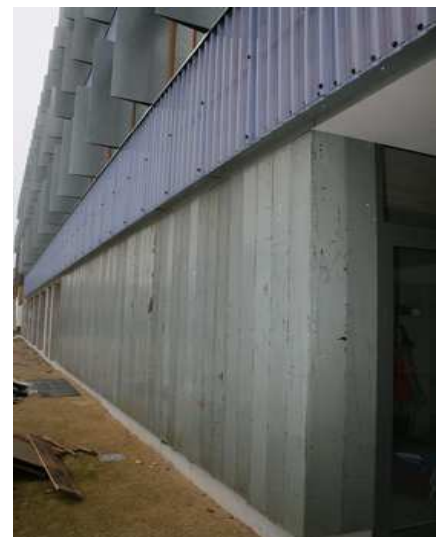
Gevelbekleding op basis van hergebruikte elementen bij de renovatie van het atheneum Riva Bella. Zo wordt het gebouw verbonden met de sporen uit zijn verleden, zelfs tot de met de passer getrokken lijnen toe. Een project van het architectenbureau Alain Richard.
